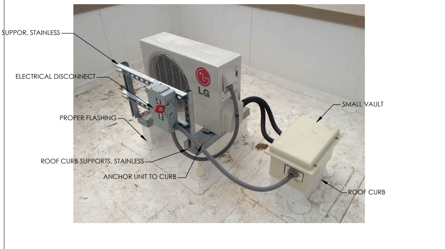
10 MINI SPLIT CONDENSING UNIT NO SCALE
